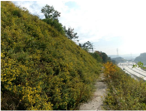
1소단 배수로 전경
