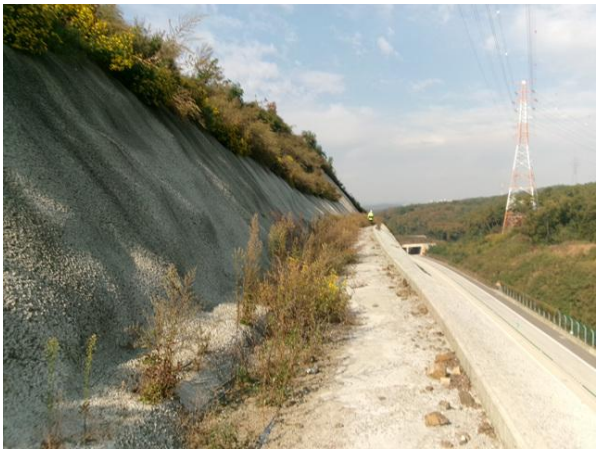
1소단 배수로 전경
